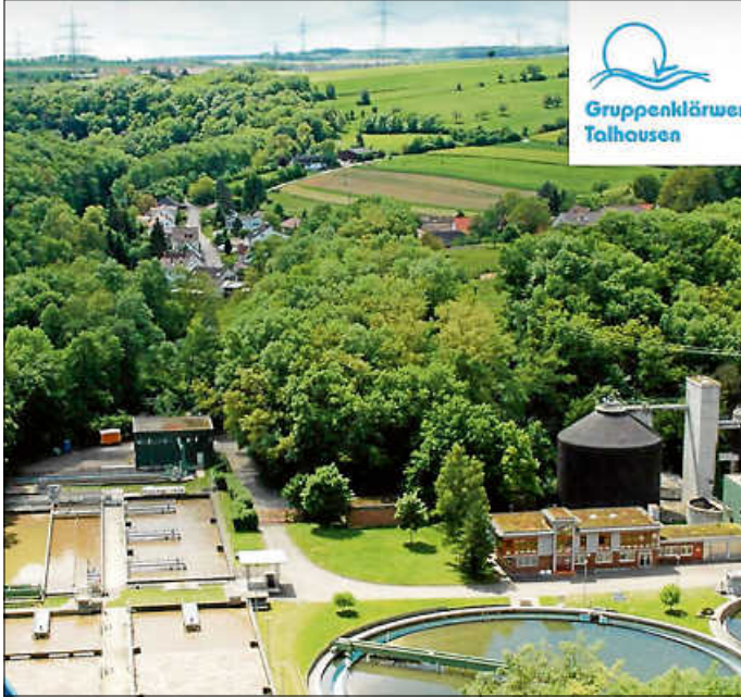
Foto: Gruppenklärwerk Talhausen
